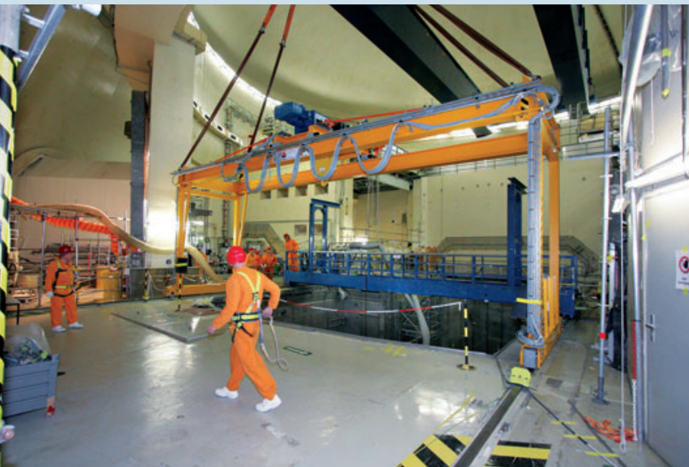
Der Kran steht auf eigenen Beinen im Kontrollbereich
