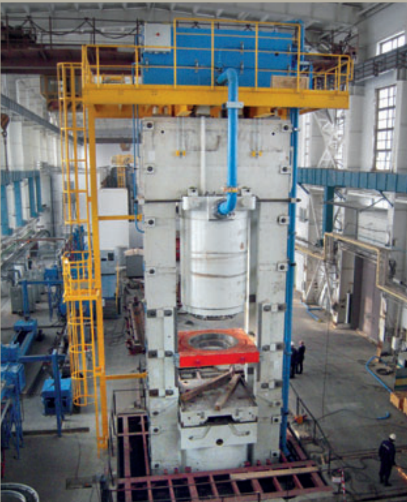
Die Presse ist im Rohbau fertig
