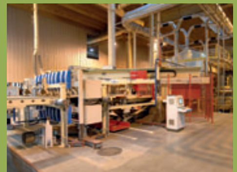
Pressenauslauf mit Doppeldiagonalsäge der neuen Spanplattenanlage
