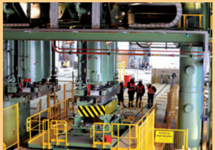
Letzte Prüfung vor dem Richtprozess
