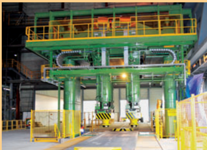
Richten des Bleches
