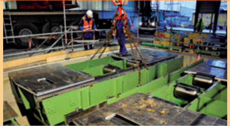
Einbau der Auflagetische
