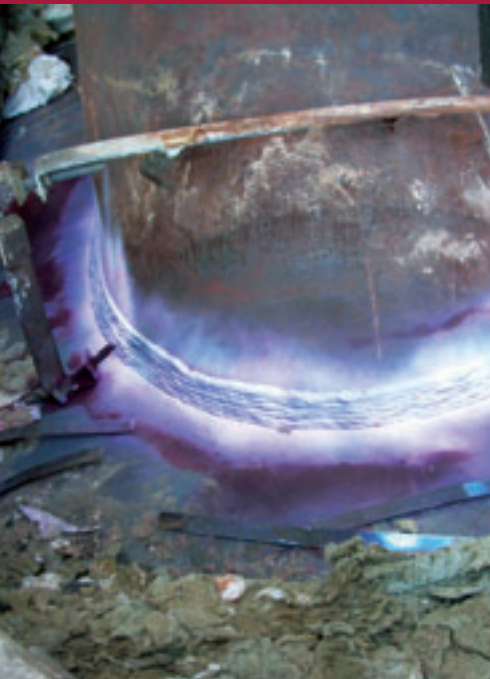
Oberflächenrisssprüfung an einer Schweißnaht
