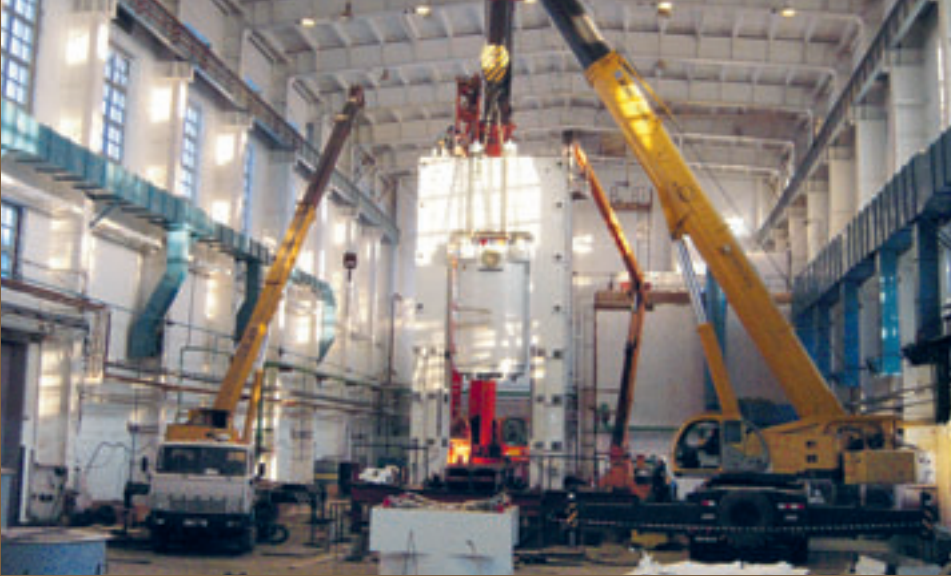
Montage des oberen Zylinders
