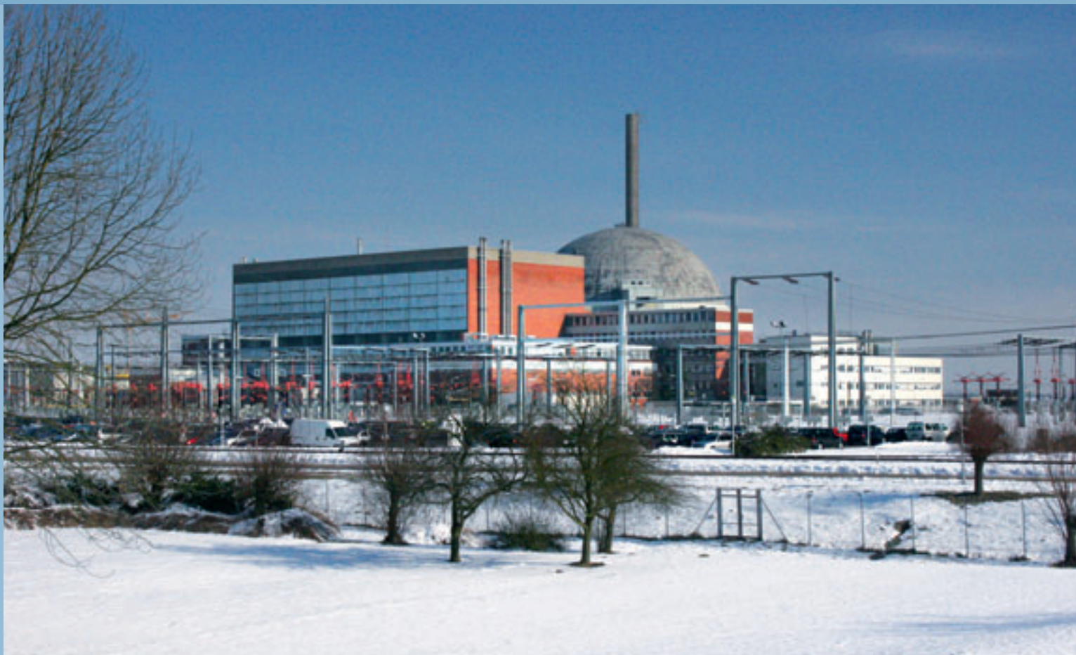
Das im Rückbau befindliche KKW Stade
