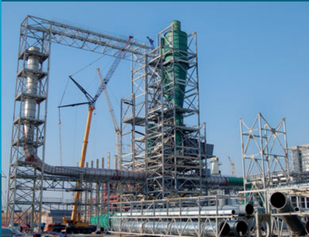
Montage des Faser-Trockners
