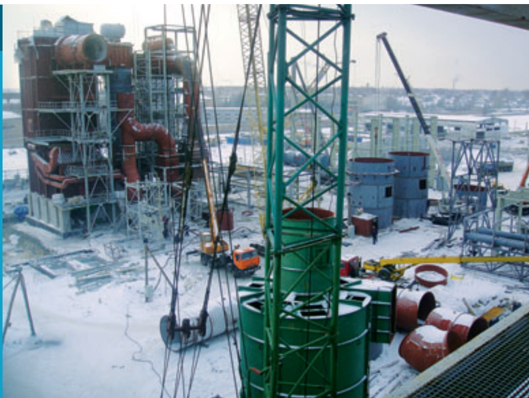
Schnee und Kälte auf der Baustelle
