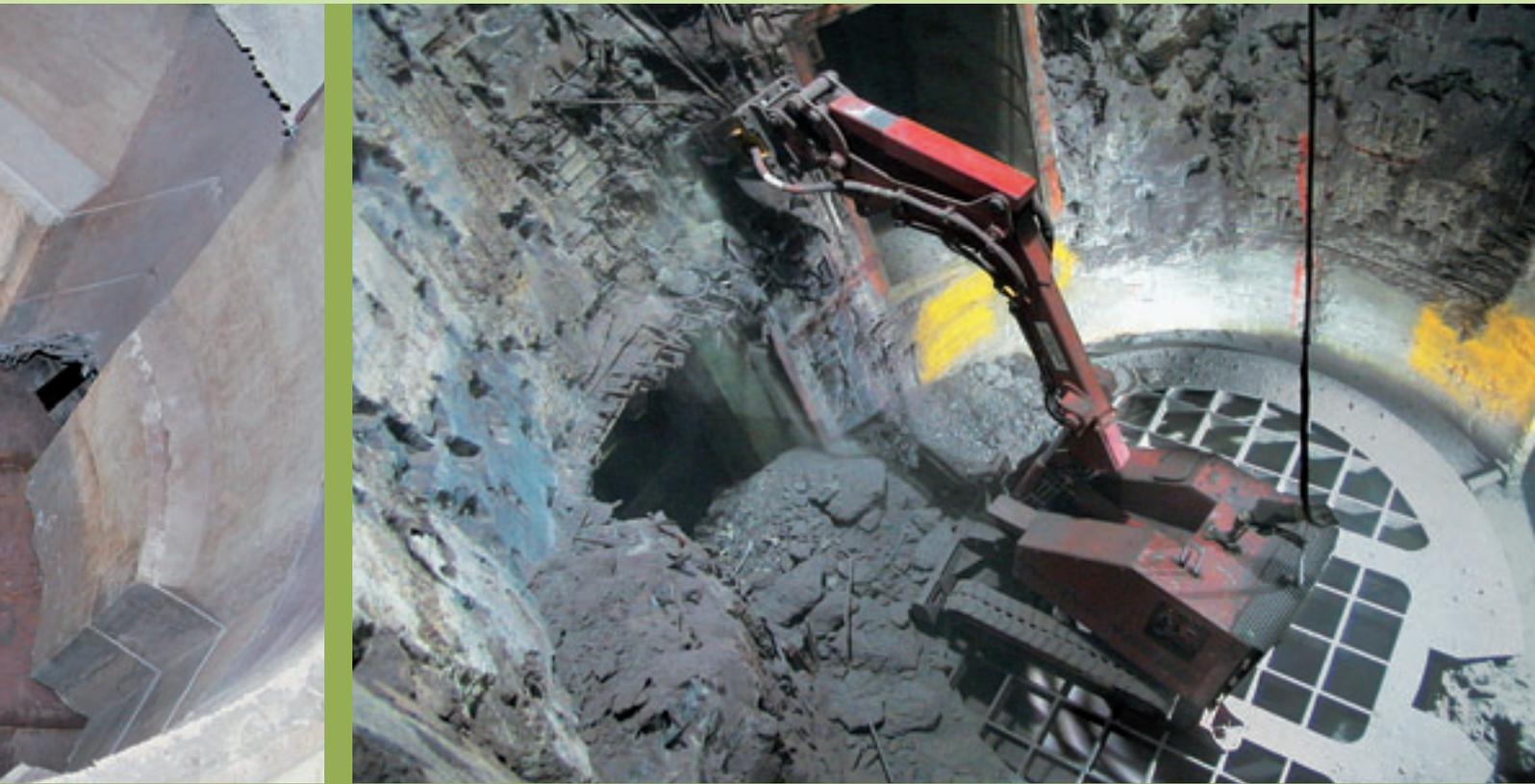
Rückbau des Biologischen Schields: Einbringung des Demontagebaggers und ferngesteuerter Rückbau
