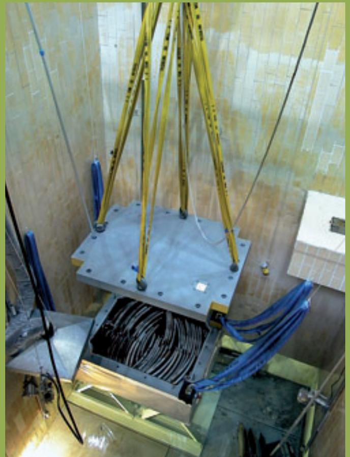
Einbringung der zerlegten RDB-Segmente in Lagercontainer
