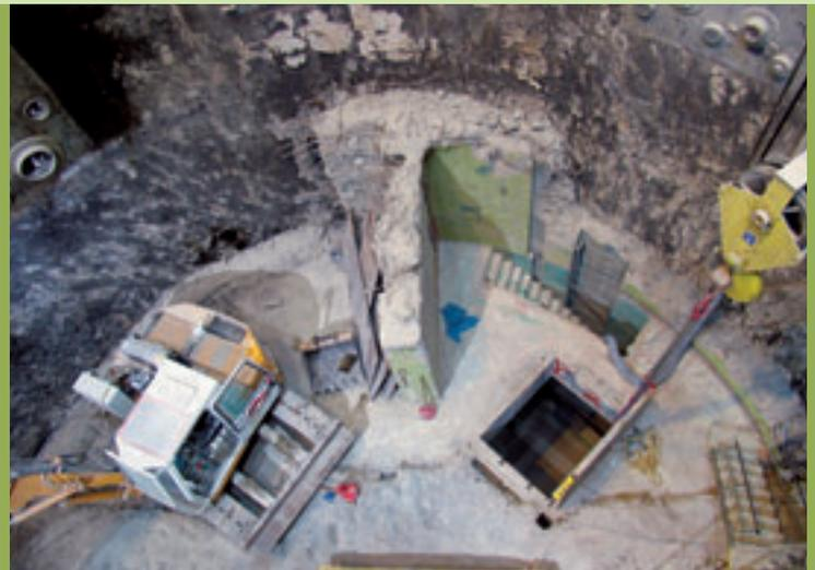
Entkernung des Reaktorgebäudes: Demontagebeginn von +18 m, Ende bei -20 m
