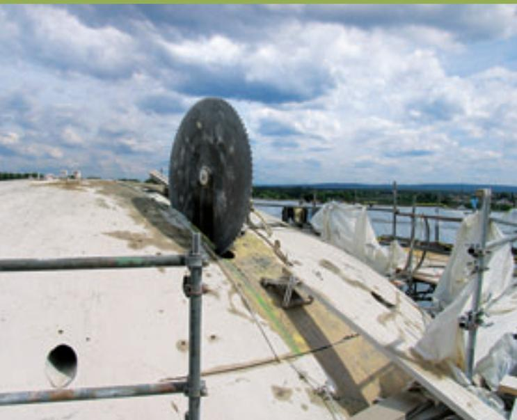
Sägen des Kuppelsegmentes mit der Betonblattsäge
