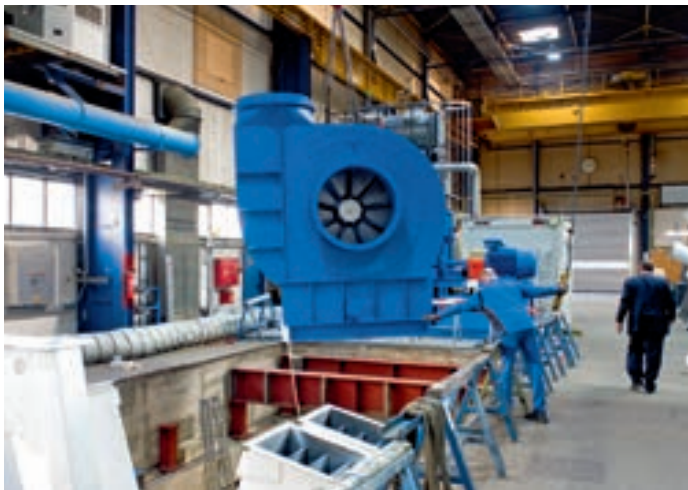
Links oben: Einheben des Ventilators; unten: Schweres Gerät im Einsatz
