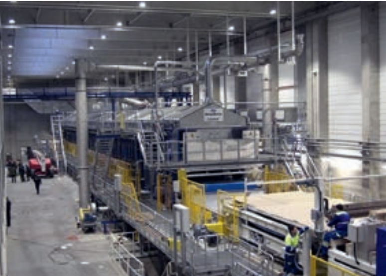
Montagearbeiten an Mattenbedüsung
