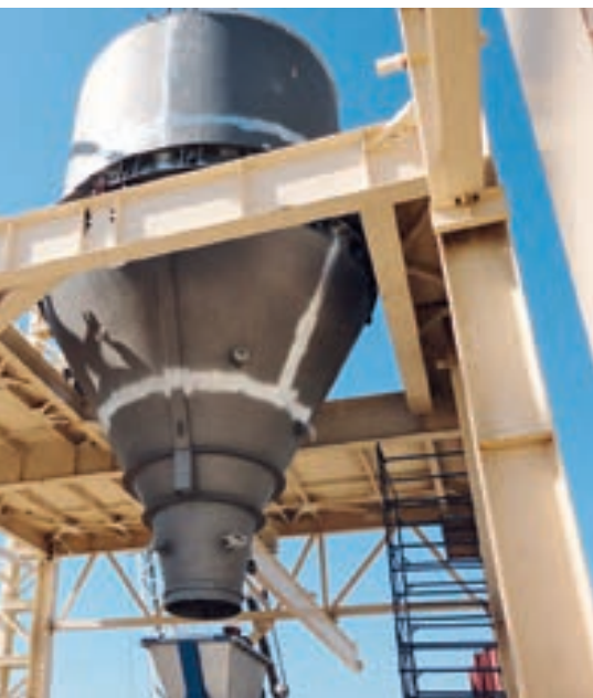
Montage des Hackschnitzelbunkers
