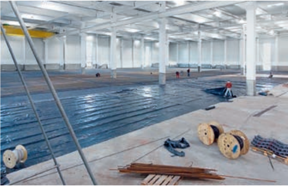
„Work in progress“: Bodenarbeiten in der Halle im März 2017
