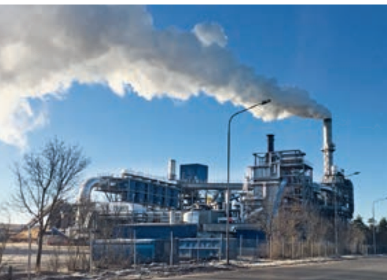
Camsan Entegre, Hendek-Sakarya, Türkei: Büttner-Fasertrockner und Energieanlage für die neue MDF-Linie
